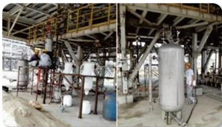
固体废弃处理
